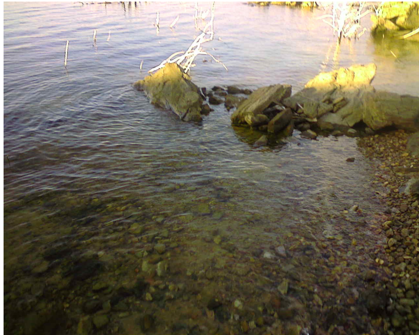
Figura 4 - Montante da barragem de Umarí (ponto um), Upanema (RN), 2012.
