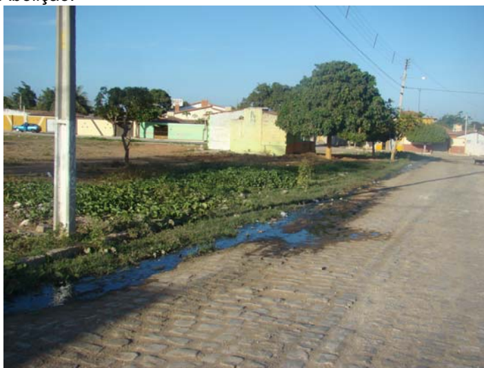
Figura 79 - Esgoto a céu aberto em rua localizada no bairro Abolição.
