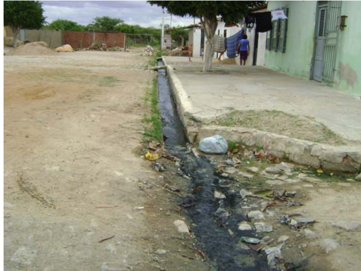
Figura 52 - Esgoto a céu aberto observado em rua do Bairro Alto da Conceição.
