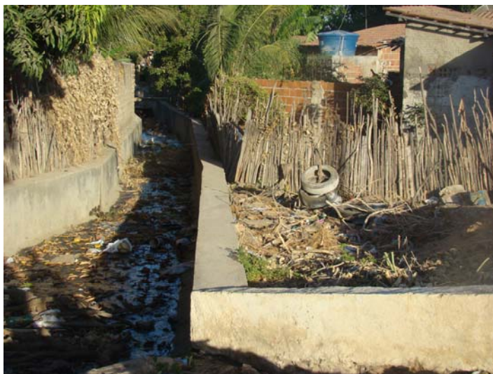
Figura 72 - Casas localizadas ao longo de canal repleto de lixo (Bairro Abolição).
