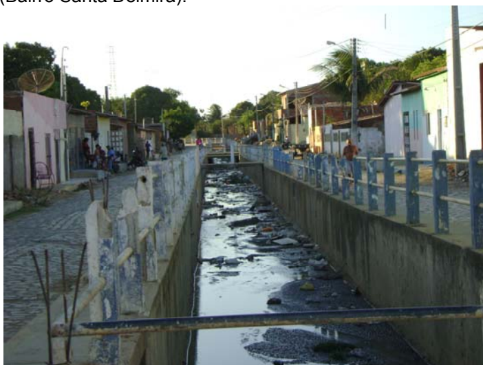
Figura 84 - Canal localizado no conjunto Parque das Rosas (Bairro Santa Delmira).
