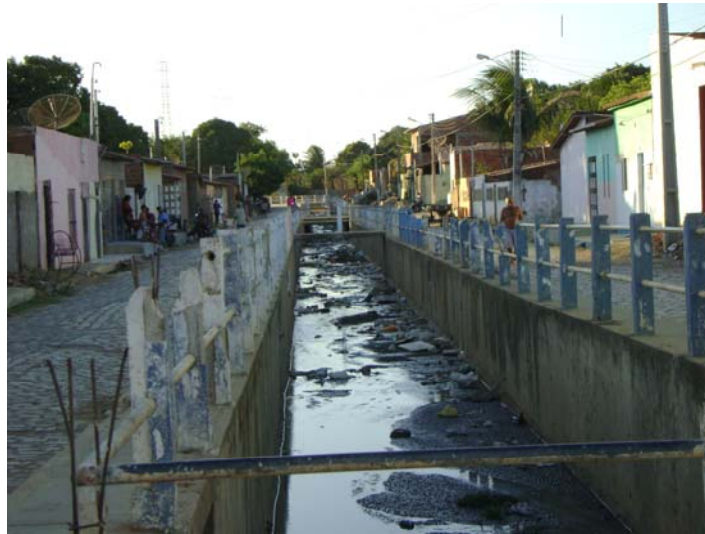
Figura 48 - Situação de esgotamento sanitário verificada no Bairro Abolição.
