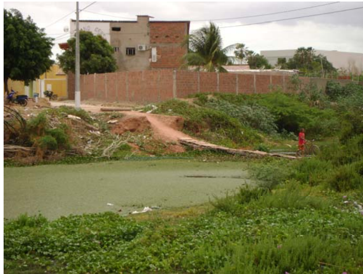
Figura 75 - Casas localizadas ao longo de canal repleto de lixo (Bairro Abolição).
