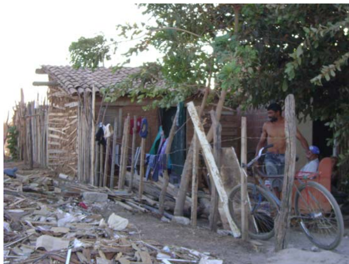
Figura 73 - Moradia precária localizada no Conjunto Wilson Rosado.
