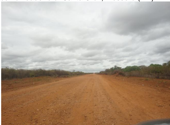
Figura 64 – Estrada (não pavimentada) que liga Mossoró a Upanema BR-110 que dá acesso a comunidade rural Santa Cruz, Mossoró (RN).
