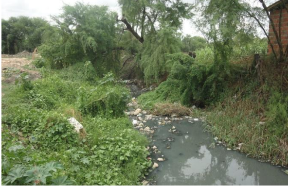
Figura 56 – Lançamento de efluentes no Rio Apodi-Mossoró, bairro Alto da Conceição, Mossoró (RN).
