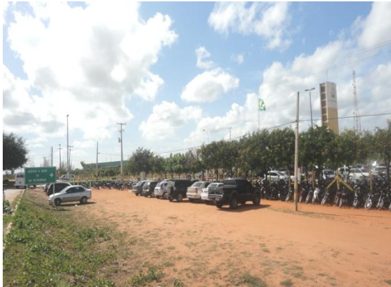
Figura 27 – Base da Petrobras, as margens da BR-304, Mossoró (RN).
