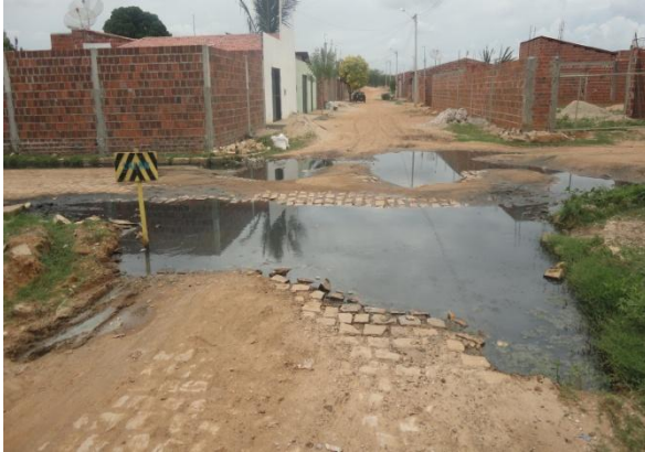
Figura 45 – Esgoto a céu aberto, má condições da via e ausência de calçamento, bairro Aeroporto, Mossoró (RN).
