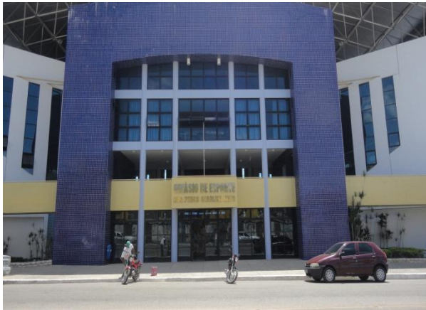
Figura 25 – Ginásio Poliesportivo Pedro Ciarline, bairro Paredões, Mossoró (RN).
