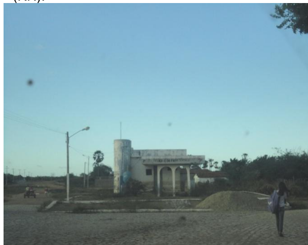
Figura 63 – Posto policial desativado, comunidade rural Passagem de Pedra, Mossoró (RN).
