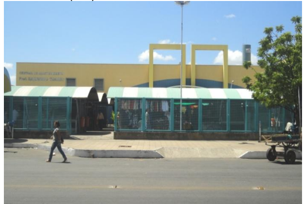
Figura 28 – Central de abastecimento de frutas, verduras, cereais e frigorífico, bairro Paredões, Mossoró (RN).
