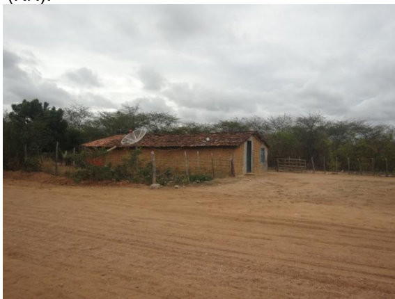
Figura 66 – Casa de taipa e sem iluminação na comunidade rural de Santa Cruz, Mossoró (RN).
