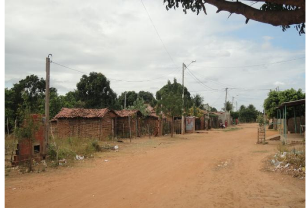
Figura 46 – Casas de taipa e falta de pavimentação na favela do fio, bairro Santa Delmira, Mossoró (RN).
