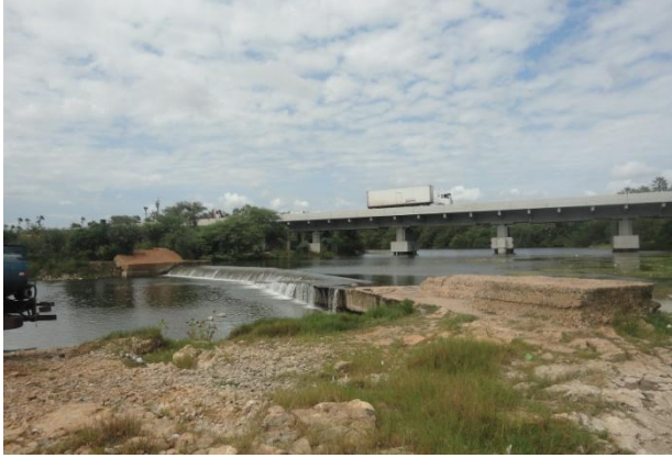
Figura 32 – Barragem do Genésio, bairro Belo Horizonte, Mossoró (RN).
