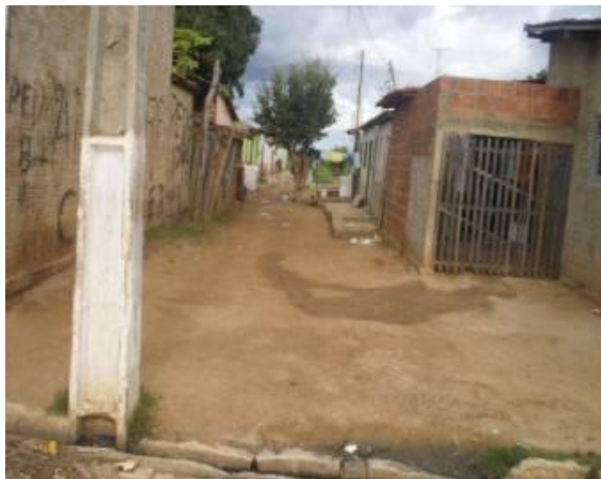
Figura 02 – Falta de pavimentação e serviços de saneamento em área periférica do município de Mossoró – RN/Brasil.
