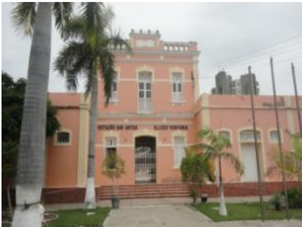
Figura 23 – Estação das Artes Eliseu Ventania, bairro Centro, Mossoró (RN)
