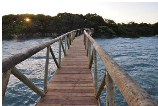
FIGURA 07: Passarela de Acesso ao Ecossistema Manguezal
