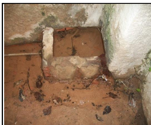
FIGURA 64- Encanação feita para aproveitamento das águas da nascente com área alagada
