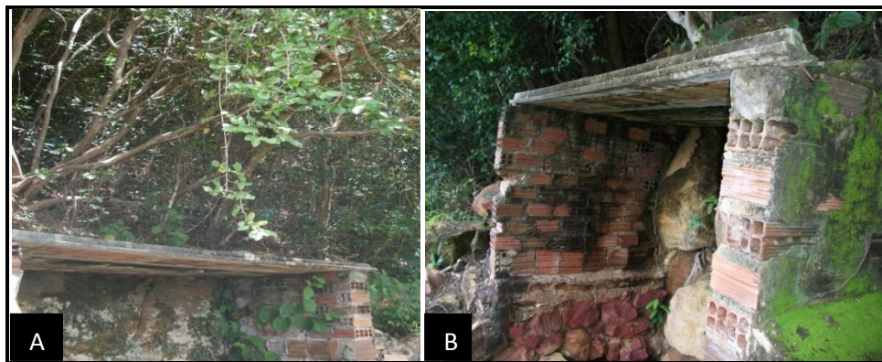
FIGURA 67- A) e B) Estrutura de tijolos ao redor da nascente.
