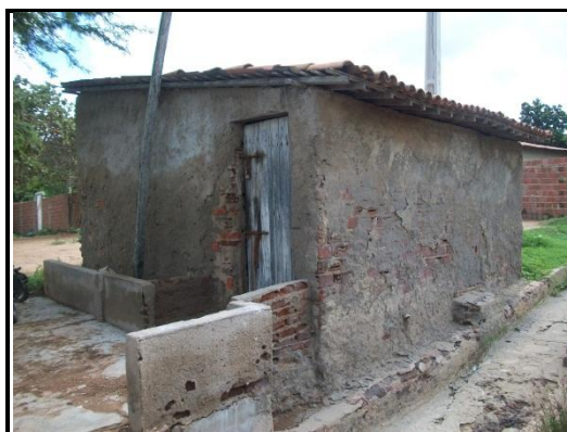
FIGURA 51- Matadouro clandestino a montante da nascente
