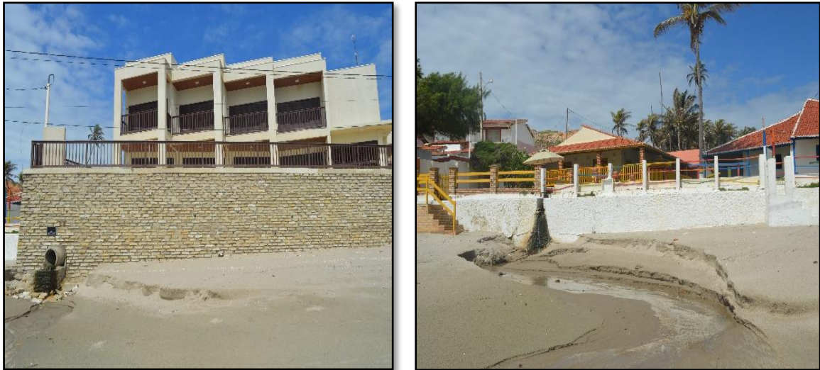
Figura 19 – Saídas de esgotos oriundas das casas de veraneio na orla de Tibau (RN).
