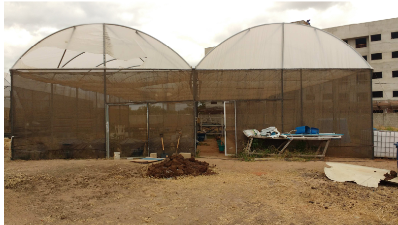
Figura 7. Vista externa da estufa.
