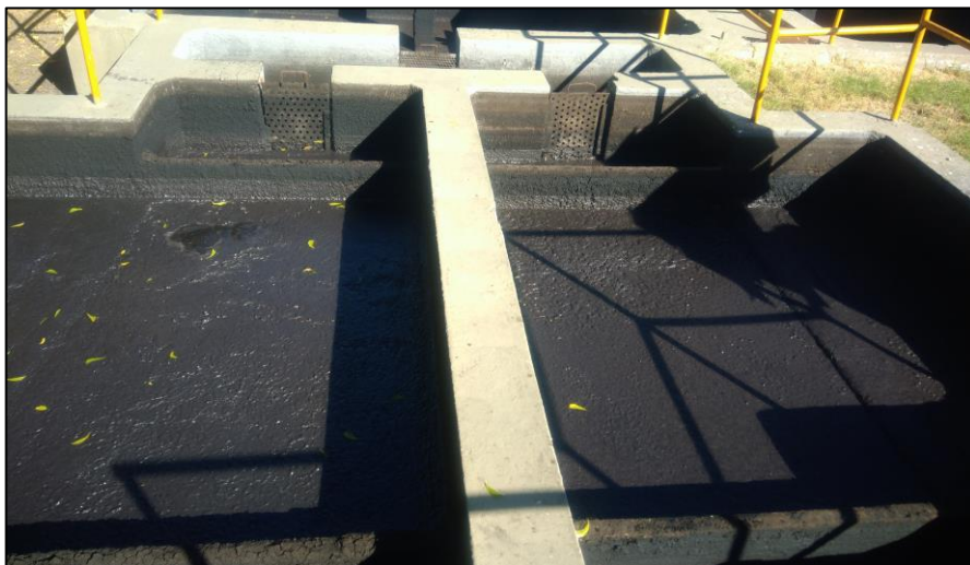
Figura 8: Tanque de recebimento de efluente da IBC
